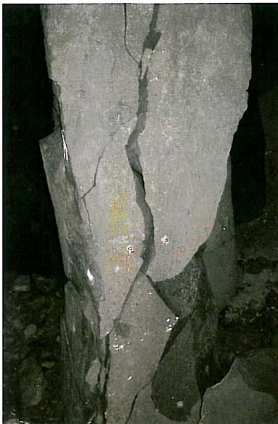
Bild 6. Durch Überlastung stark deformierter Restpfeiler mit Felsspion.
