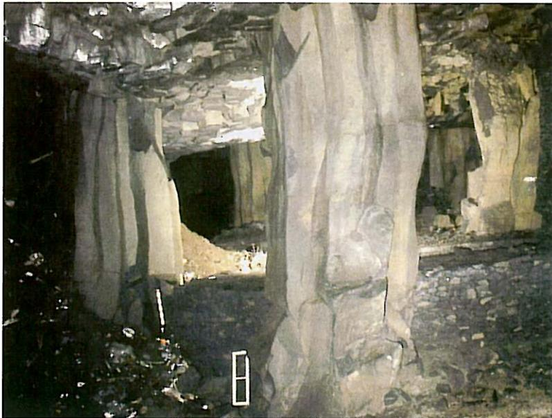
Bild 4. Typischer Hohraumbereich, Höhe etwa 5 bis 6 m, Durchmesser der Stützpfeiler 2 m.
