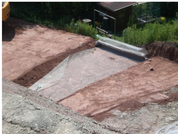
**Abbildung 3: Herstellung der Bewehrten Erde-Konstruktion, links lagenweise Verdichtung, rechts: Herstellung des Umschlages**
