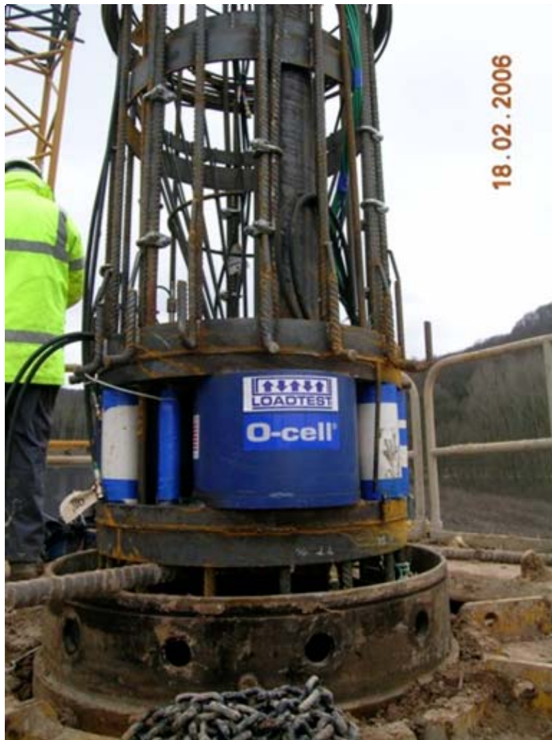
Bild 13: Osterbergzellen der Ebene 2 im Einbauzustand
