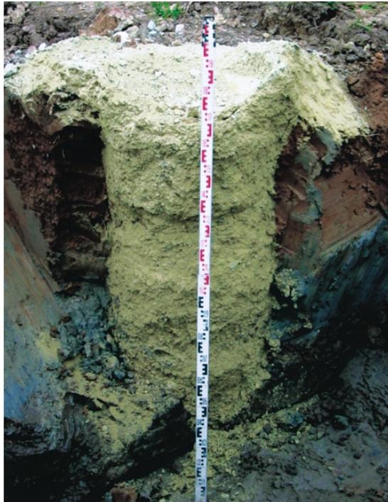
Bild 3. Aufgegrabene Bohr-Rammsäule.
