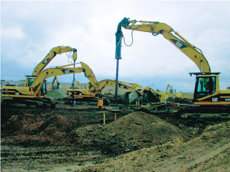
Bild 2. Für die Herstellung der Rammsäulen verwendete Geräte.
