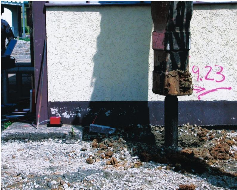
Bild 5. Herstellung einer Rammsäule unmittelbar angrenzend an Bestand.
