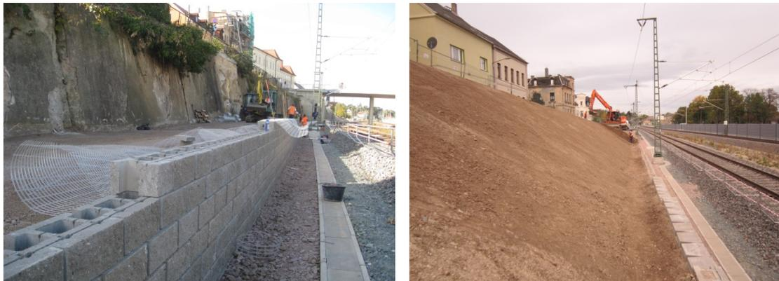
**Abbildung 5: Herstellung der Wand mit kleinem Gerät (links) und Draufsicht auf die fertiggestellte Wand (rechts)**
